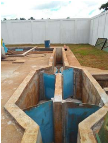
Foto 2.3 – Entrada do efluente da ETE – Calha Parshall
