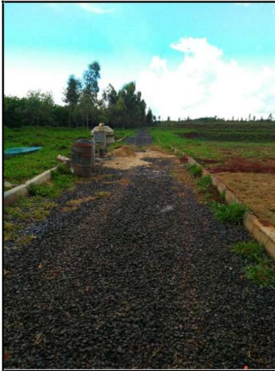
Foto 1.20 – Acesso às lagoas.
