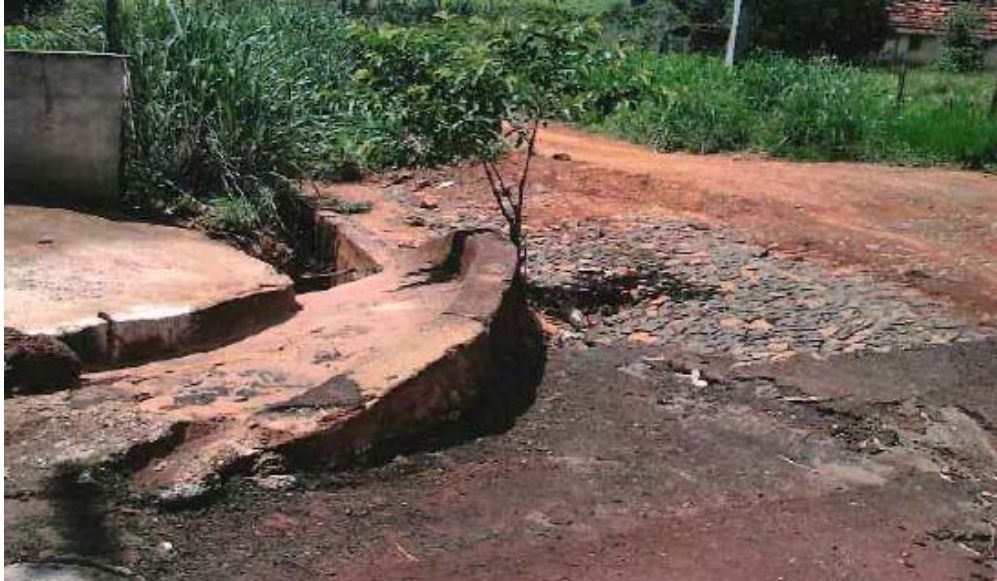
Foto 1.3 – Canal de drenagem para lançamento da água pluvial em Buriti Alegre.
