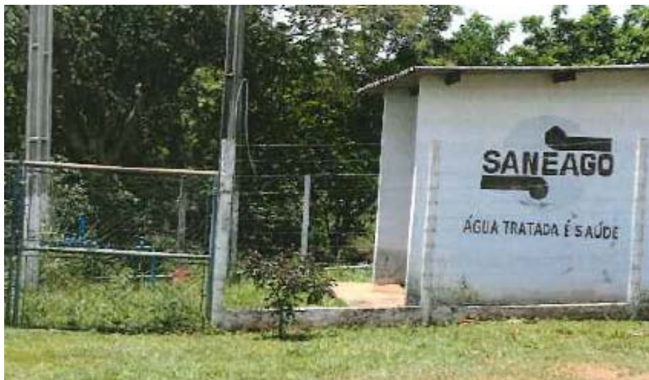
Foto 1.10 –Poço profundo do distrito de Corumbazul.
