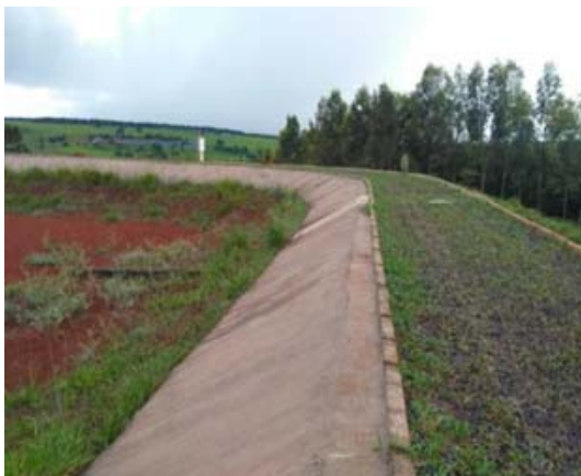
Foto 2.7 – Unidade do Sistema de Esgotamento Sanitário: ETE – Lagoa Facultativa
