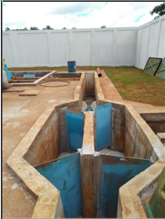
Foto 1.16 – Caixa de Areia e Calha Parshall.
