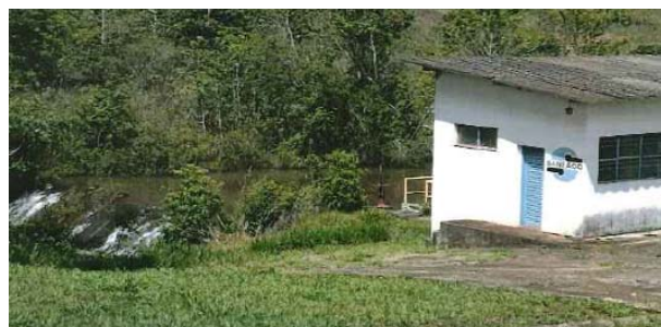
Foto 2.2 – Estação Elevatória de Água Bruta
