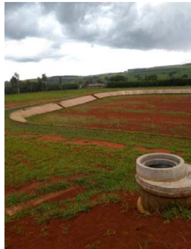
Foto 2.4 – Vista da Lagoa Facultativa da ETE
