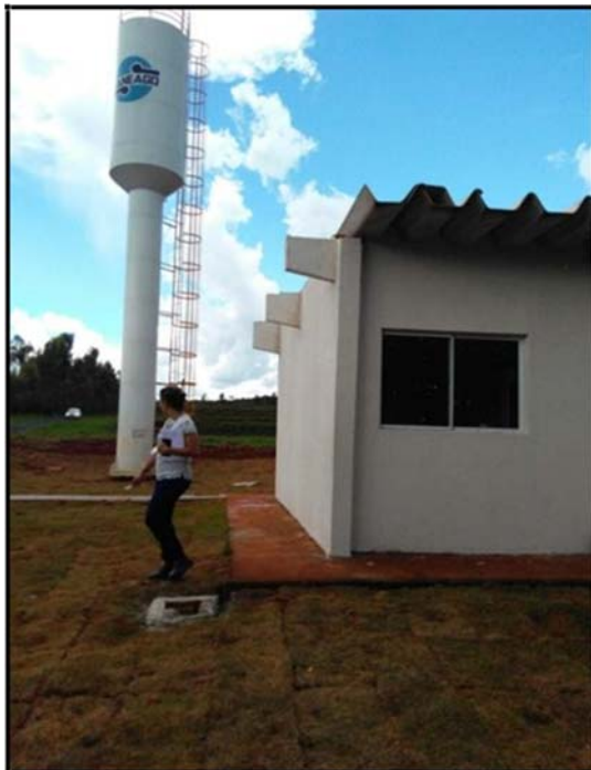
Foto 1.22 – Reservatório metálico e depósito.
