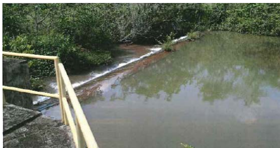
Foto 2.1 – Barragem de Captação de Água
