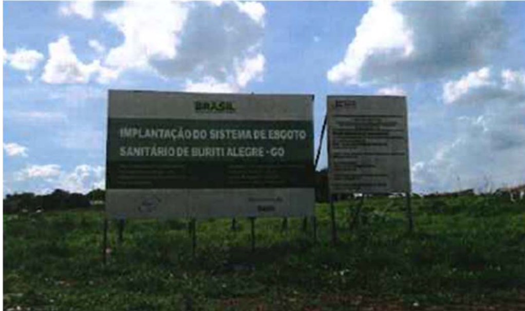
Foto 1.14 – Local de implantação da ETE de Buriti Alegre.
