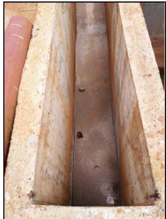
Foto 1.19 – Caixa de Areia.
