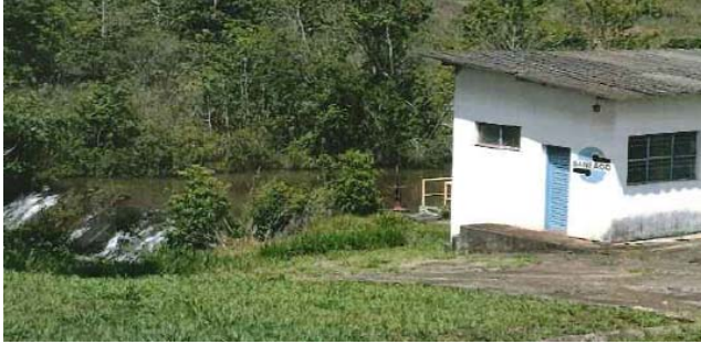
Foto 2.5 – Unidade do Sistema de Abastecimento de Água: Captação Superficial
