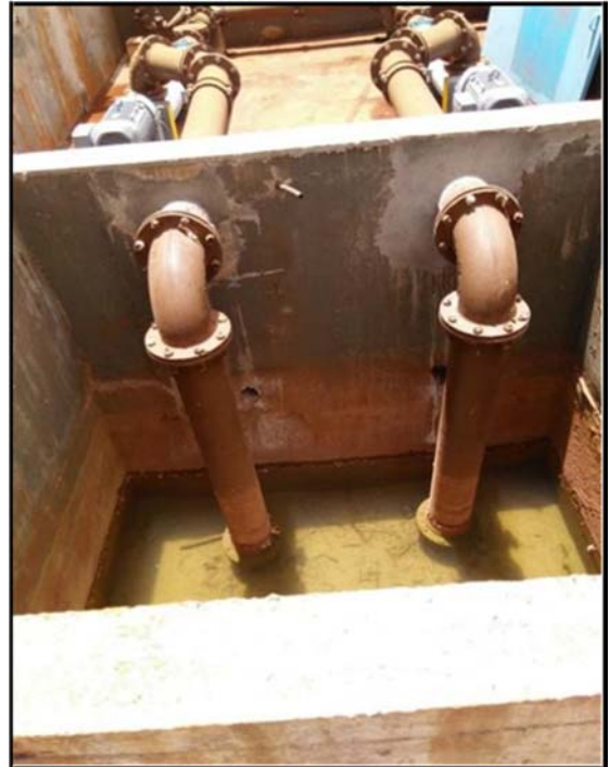
Foto 1.17 – Poço de Sucção.
