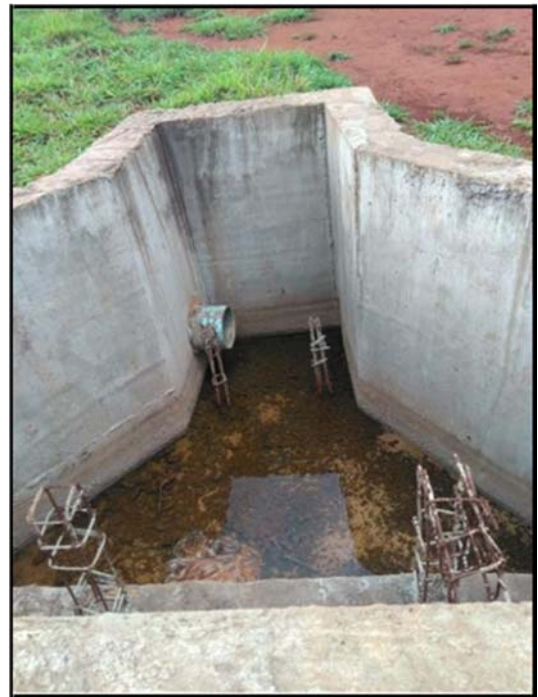
Foto 1.23 – Caixa de Distribuição.
