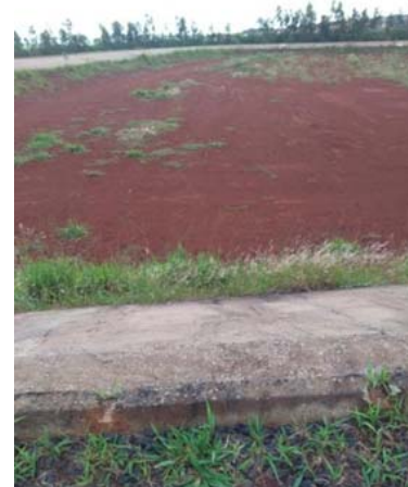
Foto 2.8 – Unidade do Sistema Esgotamento Sanitário: ETE – Lagoa Maturação
