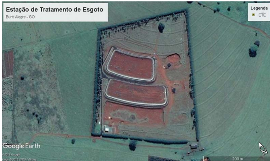
Ilustração 1.5 – Imagem de Satélite da Estação de Tratamento de Esgotos de Buriti Alegre.
