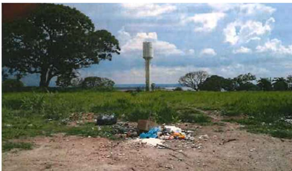
Foto 1.11 – Único reservatório da região late Clube – Poço tubular profundo -FUNASA.
