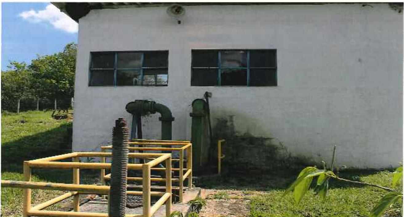
**FIGURA 119 - CONJUNTO ELEVATÓRIO DA ESTAÇÃO DE CAPITAÇÃO.**
