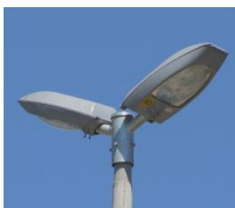
Figura 6-Representação poste 2 pétalas c/ luminárias planas.
