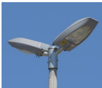
Figura 5 – Representação poste 2 pétalas c/ luminárias planas.
