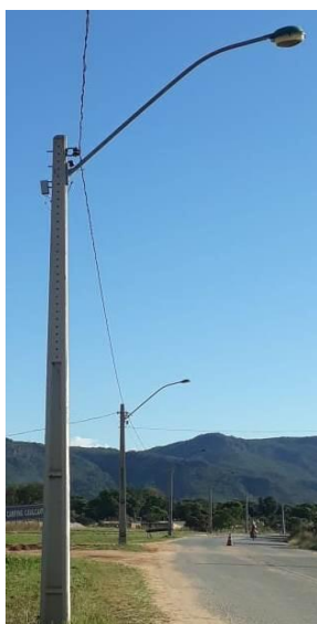
Figura 6 – Representação poste existente c/ braço metálico e luminária
